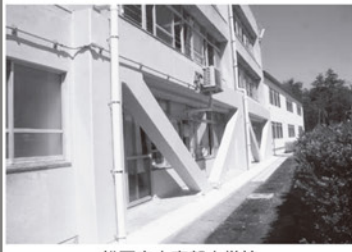
松戸市立東部小学校 校舎耐震及びトイレ改修その他工事
