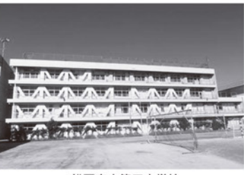
松戸市立第四中学校 校舎耐震及びトイレ改修工事
