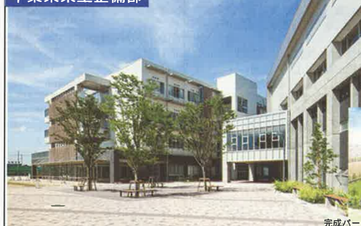
【建築場所】印西市草深 【構造・規模】 校舎:鉄筋コンクリート造2階建 渡り廊下:鉄骨造2階建 【延べ面積】 校舎:1,699㎡ 渡り廊下:27㎡
