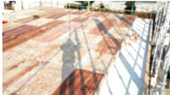
▲コンクリートの上に断熱材を敷き詰めた床を設置、ここから木造工事がはじまります。
