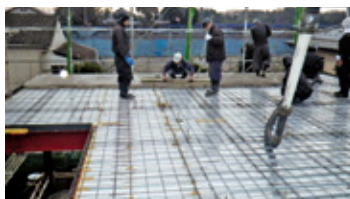
▲デッキの上にさらにコンクリートを敷き詰めます。基礎同様、この作業も職人さんの手で丁寧に仕上げます。
