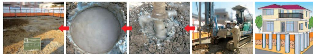
施工完了(杭頭が42か所あります) 杭頭(処理完了) 掘削しながら、コンクリートを流し込んでいます。 施工状況 セミパイロ工法
